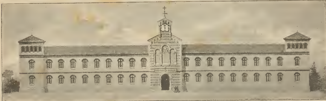
FACHADA PRINCIPAL DEL ASILO DURÁN, proyecto de D. José Peilceer
